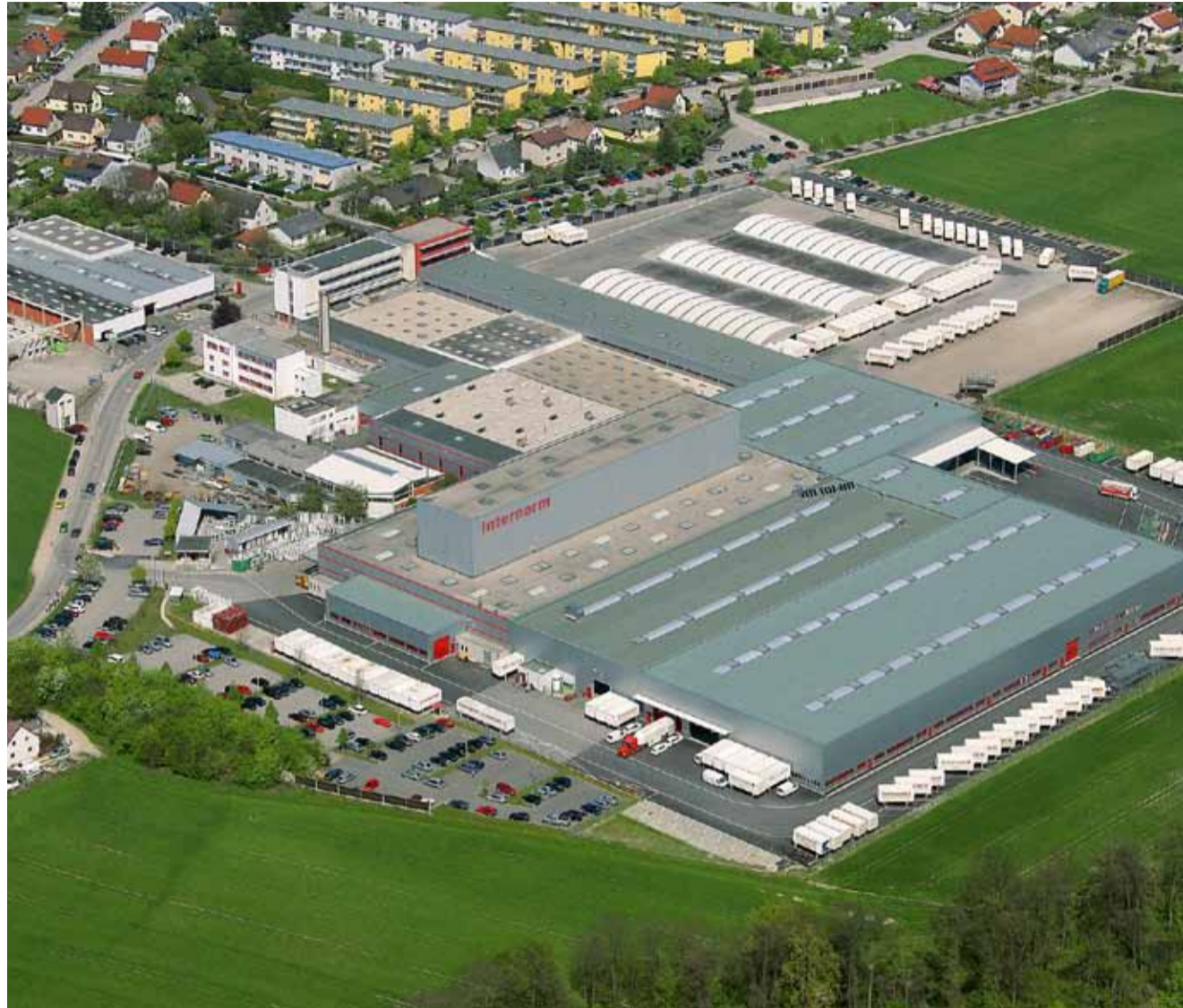
Über 18,5 Millionen Fenstereinheiten – zu 100 Prozent „made in Austria“ – haben die drei Produktionswerke Traun, Sarleinsbach und Lannach bisher verlassen. Im Bild: Standort Traun.
